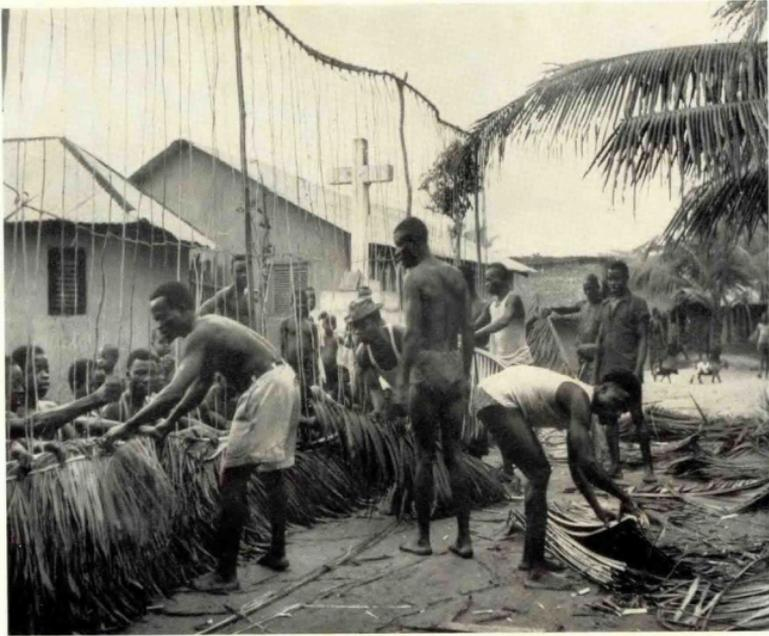
FIG. 1. — Construction collective d'un toit
